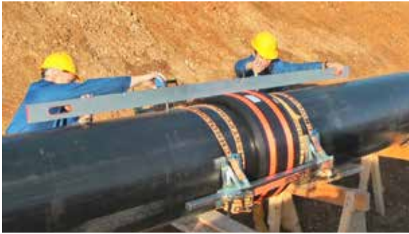
Abbildung C.21: Montage der Halteklemmen und Ausrichten des Rohrs
