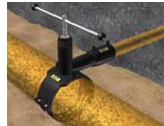
Abbildung C.35: Anbohren der Leitung
