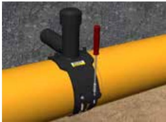
Abbildung C.33: Montage der Anbohrschelle
