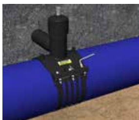
Abbildung C.37: Montage des Druckanbohrventils
